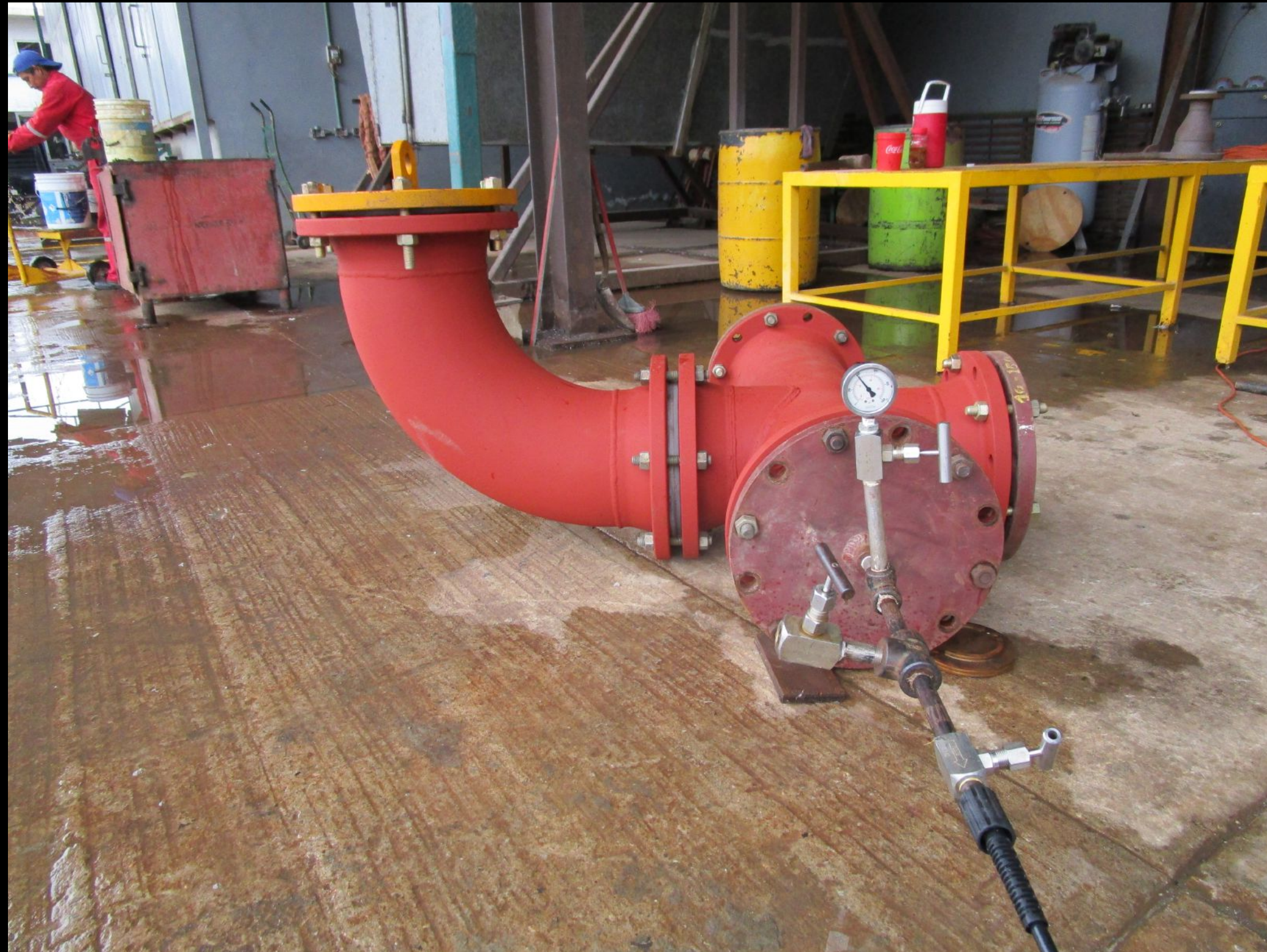
PRUEBAS HIDROSTÁTICAS A PIEZAS ROTOMOLDEADAS PREVIO A SU INSTALACION
