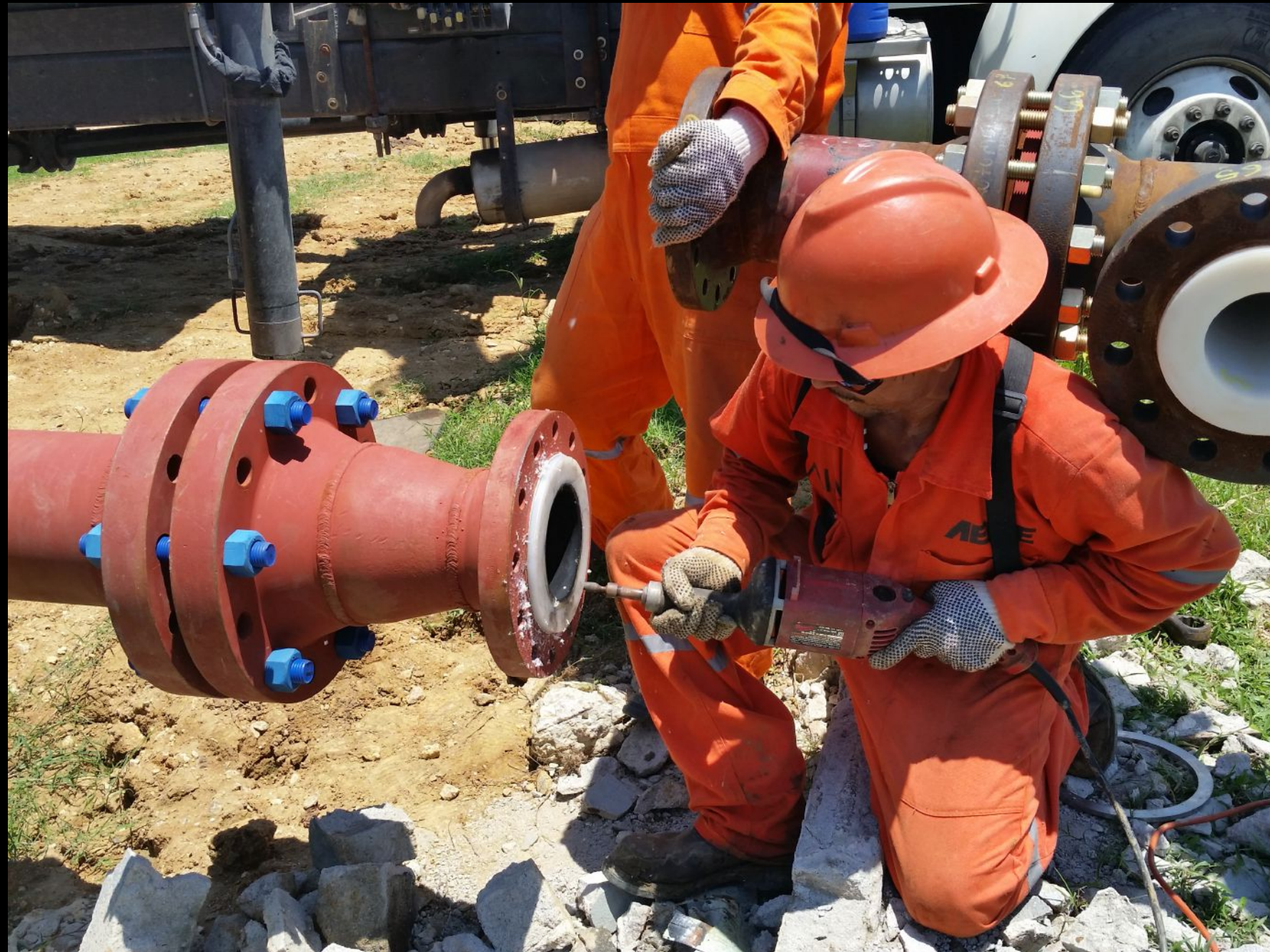
UNIÓN DE PIEZAS TERMINADO ROTOMOLDEADO, AJUSTE
