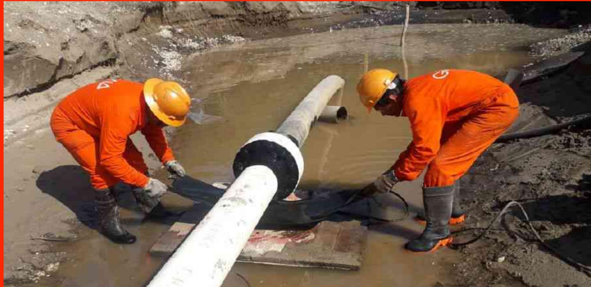
**ESTE PROYECTO ADEMÁS DE SER LA INDUCCIÓN EN UNA SOLA SECCIÓN MÁS ARGÁ DEL MUNDO, ADEMÁS DE SER UN TRABAJO DE RECUBRIMIENTO ANTICORROSIVO SE DISEÑÓ PARA REPARAR ORIFICIOS POR EL MANEJO DE ALTA CONCENTRACIÓN DE SULFÍDRICOS**
