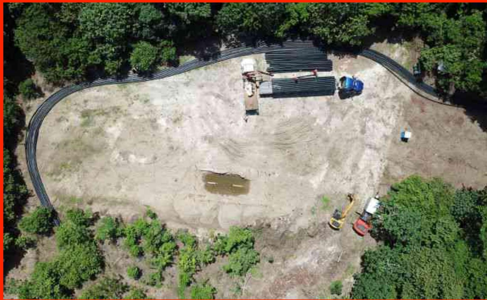
EL ENCAMISADO DE 2.1 KM EN UNA SOLA SECCION DE PERFORACION DIRECCIONAL DE OLEOGASODUCTO DE 8"Ø TAJON 101- TDR BAT PCB., ES HOY EN DIA LA INDUCCION MAS LARGA EN ESTOS SISTEMAS DE RECUBRIMIENTO A NIVEL MUNDIAL, LA COMBINACION DE CP LINER Y EXPANDA LINER FUERON USADSO PARA TAN OSADA TAREA.
