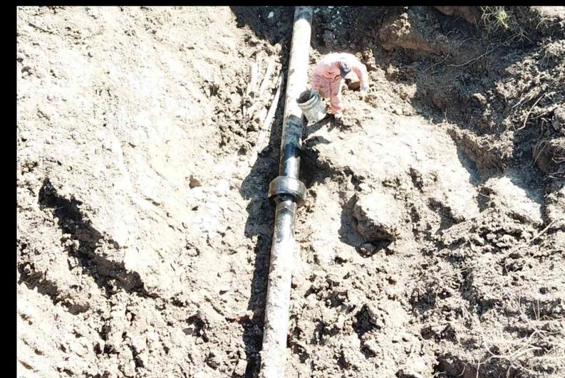
**PERFORACION DIRECCIONAL REVESTIDA INTERNAMENTE CON REPARACION DE ORIFICIO EN PUNTO MAS BAJO DEL CRUCE DE RIO**
